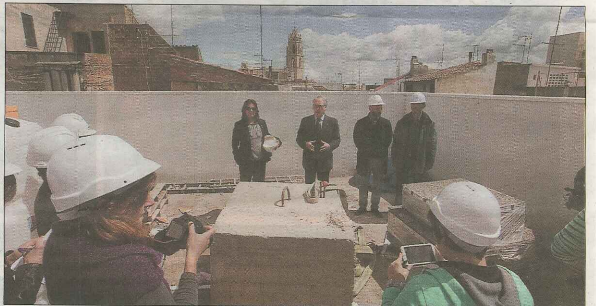
La terrassa que hi ha a dalt de l'edifici és un dels nombrosos espais a l'aire lliure del projecte. FOTO: A. MARINÉ
